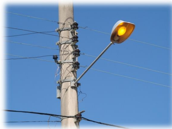
Figura 43: poste de luz
